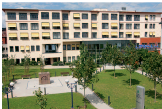
Stadtklinik Bad Wildungen: Der größte Standort der Asklepios-Kliniken Nordhessen wurde bereits auf virtuelle Desktops umgestellt.
